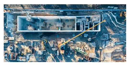
Von der Königsbrücker Straße aus sind die ersten Säulen des Neubaus kaum zu erkennen. Sie sind in einer Zeit in den Himmel gewachsen, in der noch im Minutentakt Erde und Gestein aus der Baugrube abgefahren wurden. Diese Betonpfeiler sind fest mit einer eineinhalb Meter starken Bodenplatte verbunden, die im Dezember gegossen wurde.
